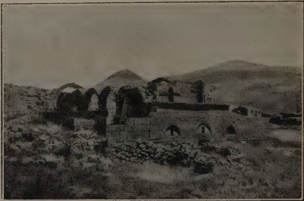
Fig. 34. — Bin-bir-Kilissé. Eglise n° 2. Façade (d'après Strzygowski, Kleinasien
